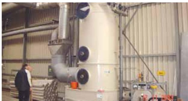
**Figura 3:** Lavador químico (cortesía: Reinluft).
