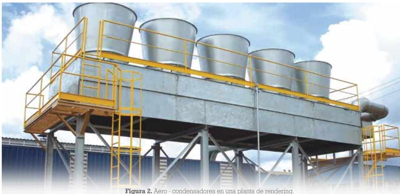
**Figura 2.** Aero - condensadores en una planta de rendering.
